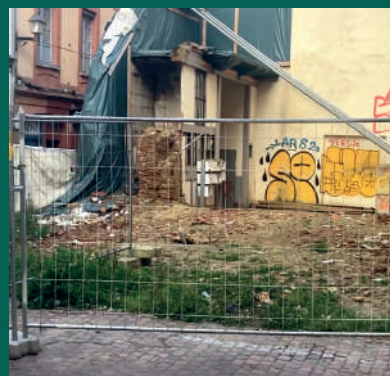
L'état actuel du 4 rue Saint Rome, un an après son effondrement, en mars 2024
